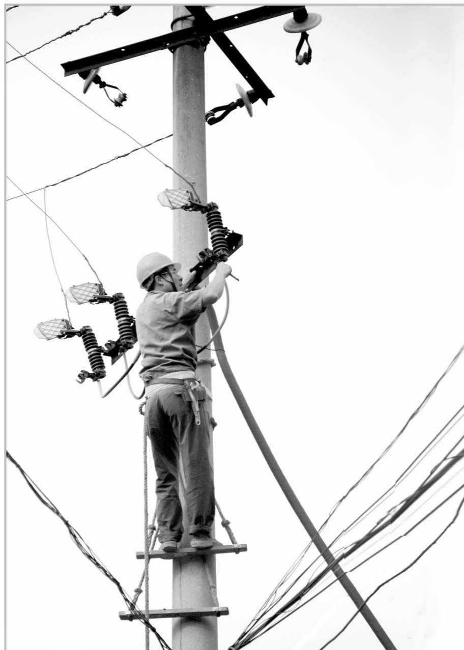
铜绿山矿水电车间着力做好矿区生产水、电和通讯的“三通”工作,通过技术改造和升级,为生产提供有力保障。图为9月7日,该矿技术人员正在进行矿区电网改造。(陈登峰 刘军 摄)
