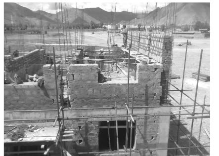
公司援藏项目—西藏雅拉香布有限公司年产10万吨优质矿产水工程从4月25日破土动工以来,目前金岳新兴建筑公司顶着高温已完成了一期工程三分之一的施工任务。图为施工现场。
