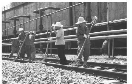
7月21日,物流公司工务段养路工在滚烫的轨道上抓紧铁路大修,确保澳炉专用线安全畅通。进入高温季节以来,物流公司各条战线上的职工仍坚守岗位,在生产一线保运输,为实现全年生产经营目标提供保障。
