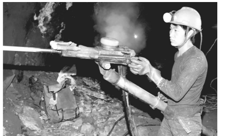
面对公司下达的矿山铜增产任务,铜绿山矿在三季度掀起了“大干一百天,安全创高产”的热潮。图为该矿坑采车间职工正在井下掘进。
