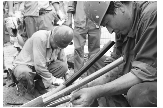
为确保夏季高温期间下陆地区生产生活用水的正常,动力分公司于日前组织维修人员对供水供电设备进行了检修。图为维修人员在检修水泵电机。(王克娇 周益良 摄)
