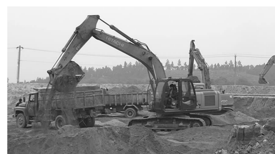
铜山口矿自恢复生产以来,积极采取措施加强尾沙坝扩容治理,目前每天正按6000立方的作业量加紧取沙工作。(胡少俊 摄)
