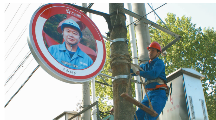
4月20日,丰山铜矿制作7块灯箱牌悬挂在主街道,上面印制了该矿劳模标兵的头像,以此来引导职工践行“责任、忠诚、学习、进取”的核心价值观。图为职工正在安装劳模标兵灯箱牌。(何永进 摄)
