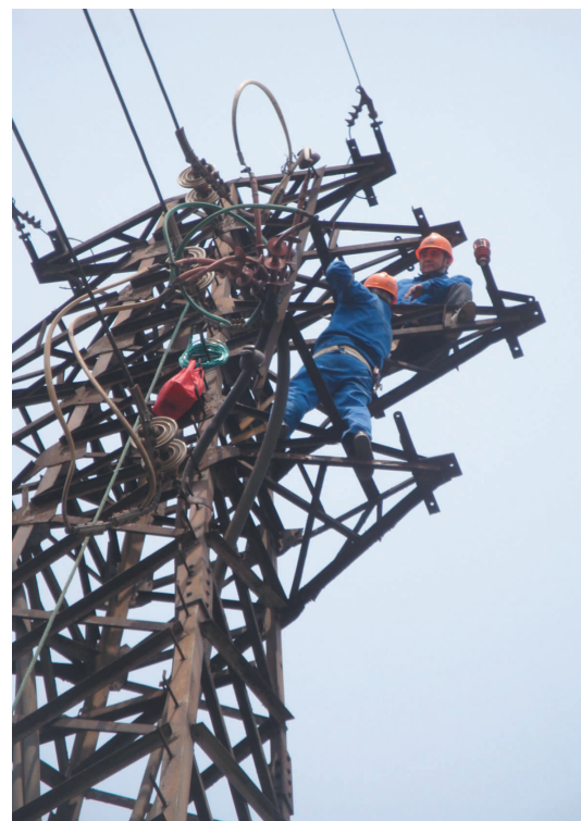
春天是雷电的多发季节。铜绿山矿从完善输电线路入手,加强输电线路的防雷措施,保障矿山电力系统的稳定运行。图为4月12日该矿水车车间外线电工更换避雷器的场景。(李细胜 摄)
