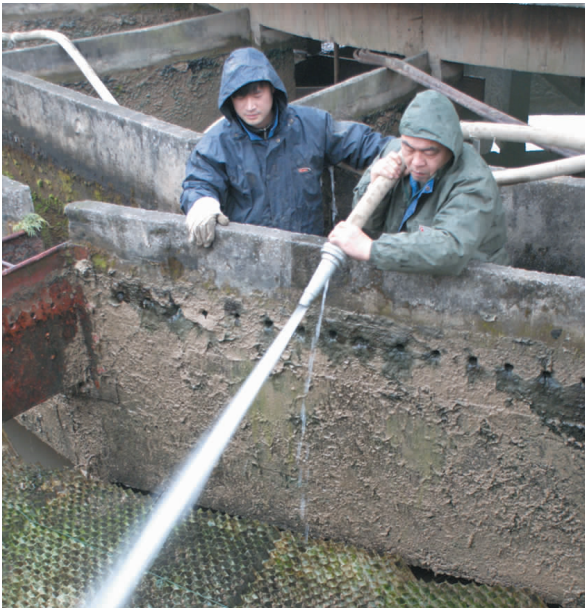
3 月 18 日动力分公司供水一车间综合班清洗 1# 澄清池,提高了清水处理能力,降低了出水浊度。图为综合班职工在冲洗池体。(刘喆 摄)
