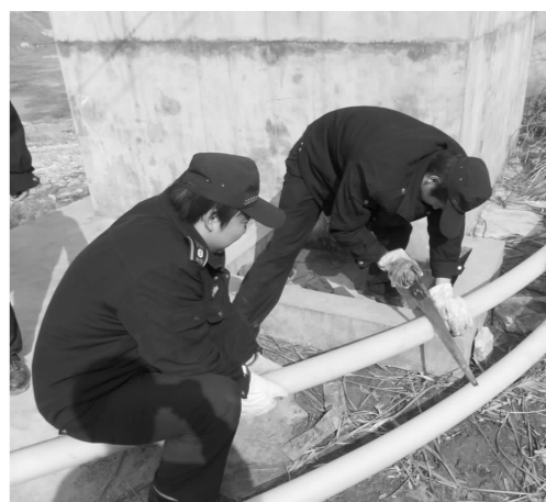
3月8日下午,铜山口矿保卫部联合东方山公安分局铜山口矿派出所对该矿尾砂库3号坝周边的个体选厂乱排尾砂管道进行拆除,共拆除管道200余米,维护了矿山的正常生产秩序。(吕晖 摄)
