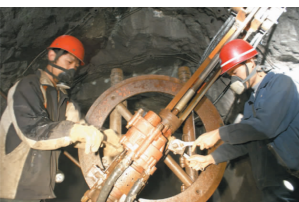
丰山铜矿井下职工正在调试设备,准备开工作业。
