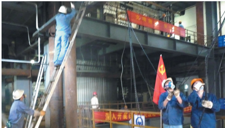
10月6日,冶炼厂加强国庆节期间奥炉建设工作,确保工程11月29日点火。图为冶炼厂维修车间职工在抓紧铺设电缆。(严春华 摄)
