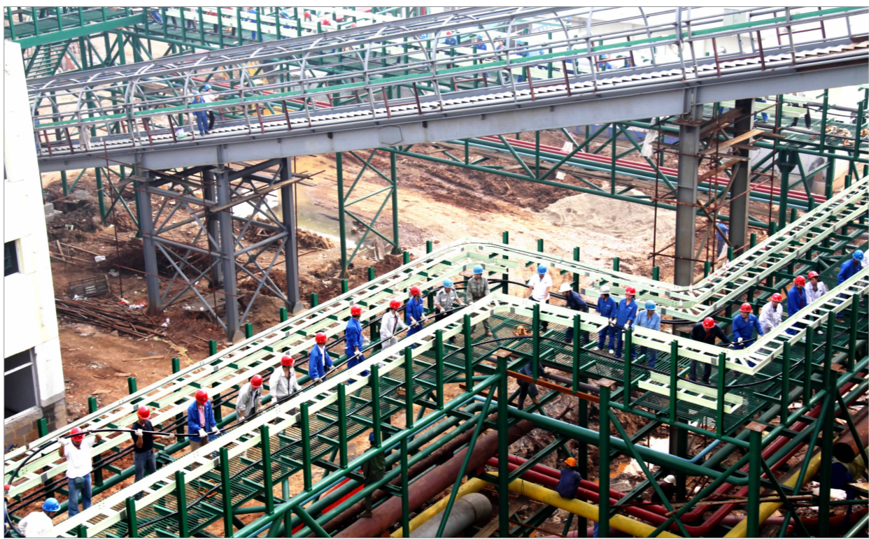
安公司为确保节能减排工程的施工进度,建立分公司经常组织机关干部室员工开展义务劳动。图为日前该公司机关干部室员工在拉电。(程玲 王军摄)
