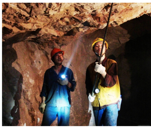
铜绿山矿坑采车间大力开展顶板管理活动,认真做好采场的顶板的安全确认,确保实现“一杜绝、五为零”的全年安全生产工作目标。图为该车间职工在处理采场顶板浮石。(若愚 摄)
