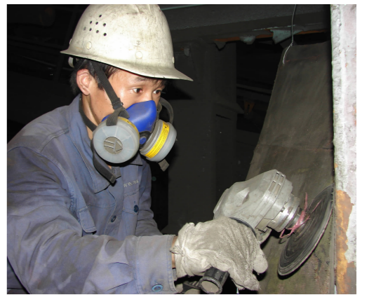
图为8月17日,职工正在对皮带头子胶结处进行打磨。(孙圣 摄)
