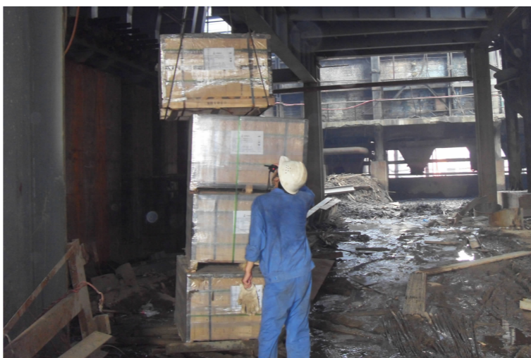
冶炼厂修炉车间职工于8月10日来到沉降电炉现场开始吊运耐火砖与浇注料,这标志着有色公司技改项目奥炉配套项目沉降电炉进入了砌筑施工阶段。图为该车间职工进行耐火砖吊运场景。(陈惠英 摄)
