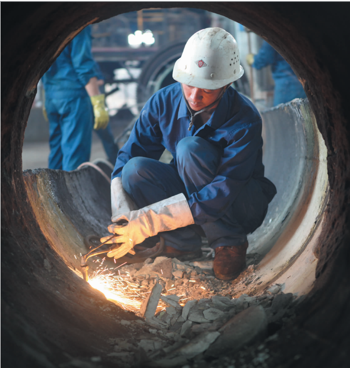
7月21日,稀贵厂开始对全厂设备进行检修,确保下半年生产任务能顺利完成,实现超利500万的目标。图为维修工正在对一车间的两台熬矾窑的窑筒进行焊切。(叶志海 摄)
