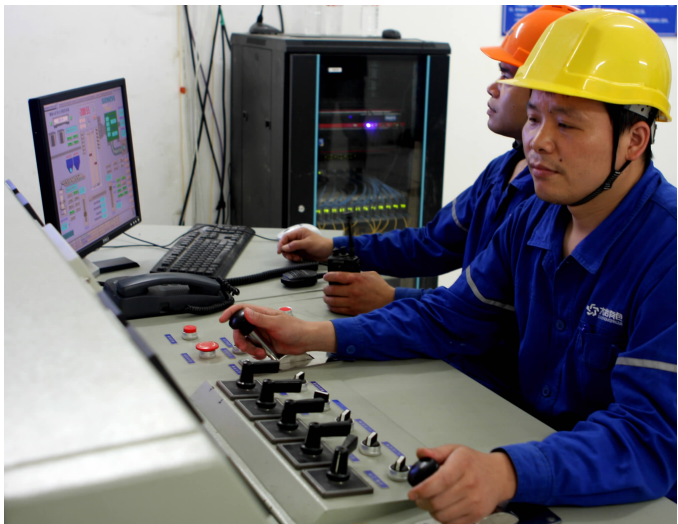
■ 职工在新建的-365 米盲主井卷扬机房提升 3 期工程的第一斗矿
