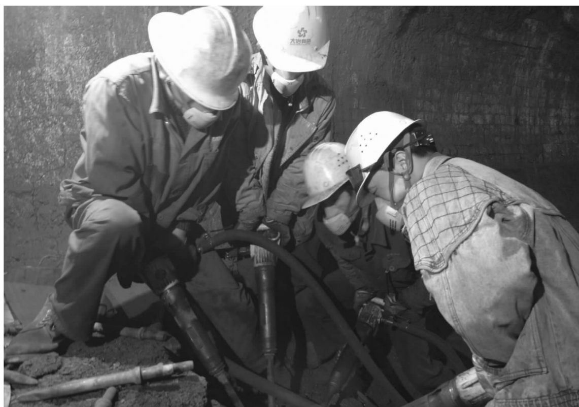
1月7日至14日,冶炼厂熔炼车间诺兰达炉检修完成打炉结工作。为了保证检修进度,诺兰达工段实行三班倒作业,四人一组,歇人不歇工轮流作业。图为该车间四名职工正在齐心协力打炉结。
