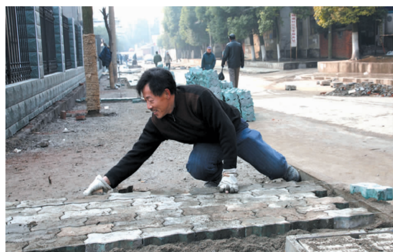
■ 建设中的体育馆南路改扩建工程
