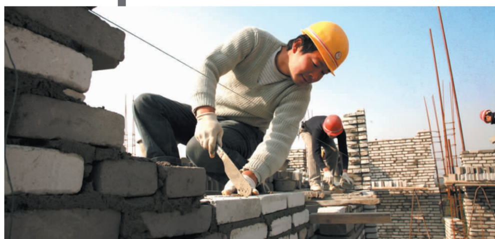
■ 正在兴建的老机修处廉租房
