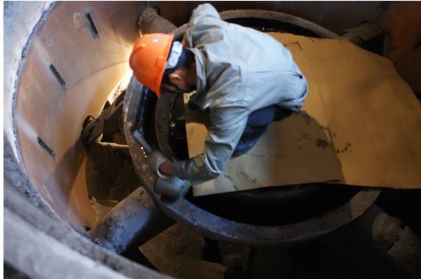
铜绿山选矿车间在年终设备检修中,突出五大特点。一是全线停车检修前,提前一周对已完成生产任务的流程和备用设备进行检修,以缓解人员、场地、时间和行车等公共用具的紧张矛盾;二是车间、工段、班组三级动员和车间领导挂点工段、工段领导挂点班组及轮流跟班,确保检修安全;三是实行检修项目责任人负责制,以确保检修质量;四是把5S问题源整治和安全隐患整改与设备检修同步推进,确保整体效果;五是实行检修项目成本控制,今年年终设备检修总预算创历史最低。 图为碎矿工段维修人员正在给细碎圆磨破碎壁灌胶。(蔡向明 余均平 摄)
