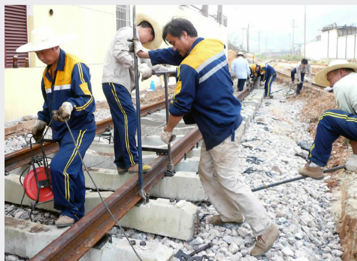
运输公司工务段承接新罐洗铁路工程以来,克服作业区域狭窄而吊车无法现场吊装作业等诸多困难,于日前提前一个星期安全优质完成了全长150米的铁路修建工程。图为运输公司工务段养路工在进行铁路线路的调试工作。(占志申 摄)
