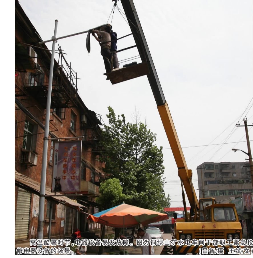
高温酷暑时节,电器设备易发故障。图为铜绿山矿水电车间干部职工紧急抢修电器设备的场景。(吕智/摄 王斌/文)
