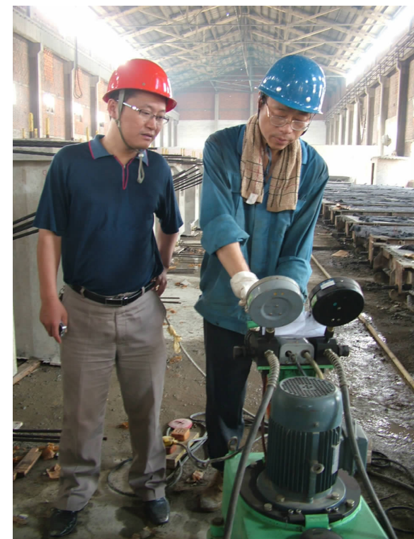
在二季度的攻坚战中,建安构件厂捷报频传:该厂6月份商品混凝土产销量9000余立方米,创历史新高;7月15日,新精矿仓84根预应力吊索又顺利进入张拉灌浆施工工序。图为7月21日在热气蒸腾的预制厂厂房内,优秀共产党员李尚德(右)正在认真读取压力表上的数据。(程玲 摄)
