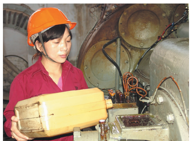
7月21日中午,铜绿山矿坑采车间机运工段风机工程组丹顶着45℃的高温,小心翼翼地给压风机加油。(高元兵 摄)
