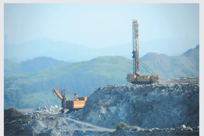
目前该矿正着力推进的露天北扩工程
