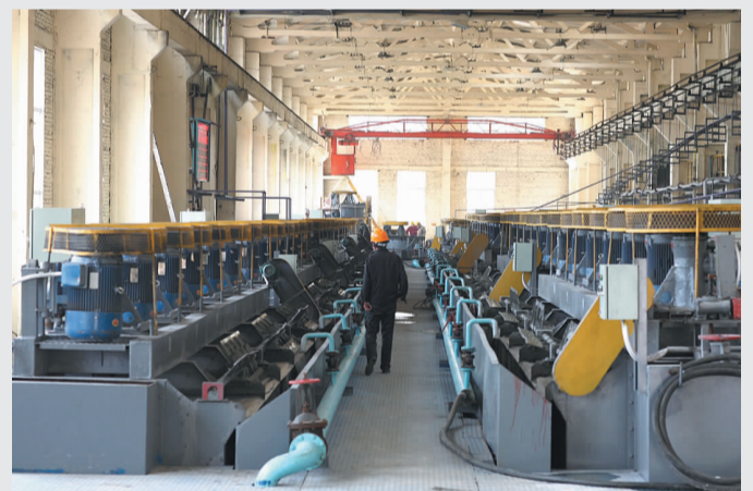
改造一新的浮选工程已投入使用
