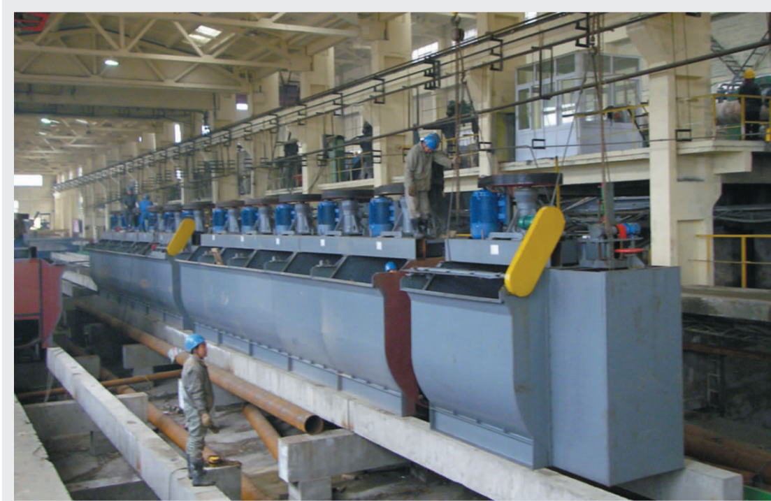
鑫泰公司投入1200万元资金,计划用45天进行选矿车间的改造、增容等项目。2月12日改造项目工作与年终检修一并进入施工阶段。图为建安公司协助完成的改造项目之一的新浮选机的英姿。(张珍意 摄)
