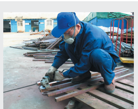
冶炼厂电解二车间钳工班日前利用工余时间对废旧的导电棒进行修复,在半个月的时间里修复大板导电棒1000多根。图为职工正在打磨焊接后的导电棒。(陈祖加 摄)
