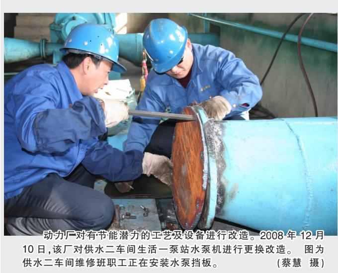
动力厂对有节能潜力的工艺设备进行改造。2008年12月10日,该厂对供水二车间生活一泵站水泵机进行更换改造。图为供水二车间维修班职工正在安装水泵挡板。(蔡慧 摄)
