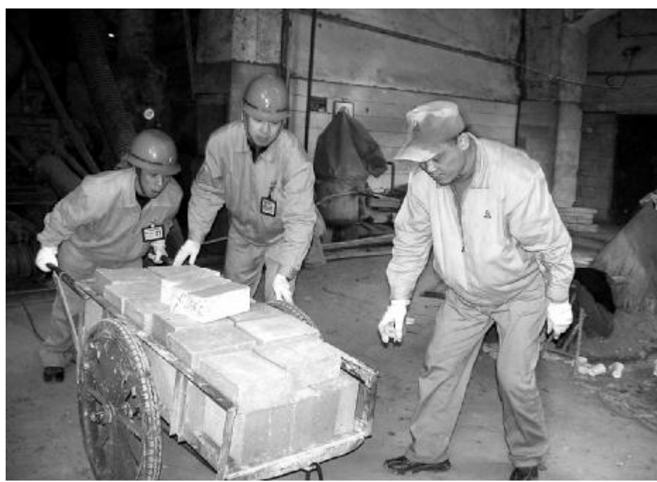
11月26日下午,氧化铝一厂电气车间党员在党支部的带领下积极正在3号熟料窑检修的工程设计总公司运通耐火砖。
