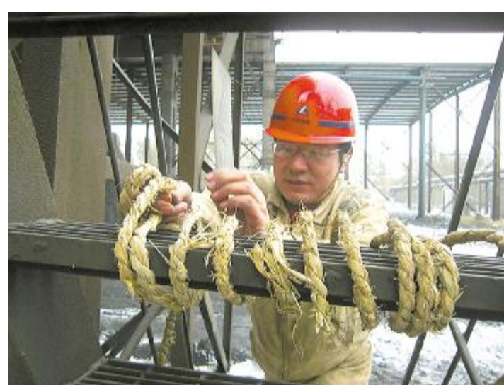
为应对突如其来的寒流和冰雪侵袭,日前,热电厂员工积极动手,组织开展了冬季“五防”工作。图为热电厂燃化车间员工正在为天车上楼梯梯防滑。康宏波 摄影报道
