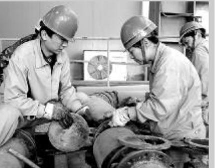
氧化铝一厂八车间积极落实两级公司年中工作会议精神,9月21日,车间组织员工更换了新齐盘料浆的阀门,确保设备安全度过国庆长假。
