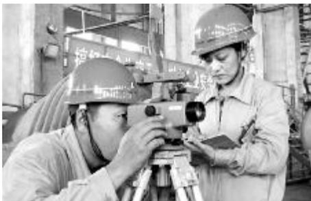
7月14日至19日,工程公司先后组织了5个车间的机械、电气、土建专业的50名检修员工,对50万吨选矿厂磨浮车间磨粉系统原有的减速机、电动机进行了整体更换,同时对分机和高、低压泵进行了常规检修。因为测量工正在对球磨机进行找正。
