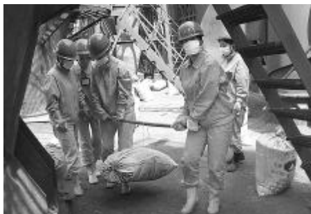
热电厂党委在学习实践科学发展观活动中,注重解决基层的实际困难。本着基层分线原则,近日,机关党委组织党员和管理人员五十余人,对锅炉车间技改施工项目中堆积的大量建筑垃圾进行了清理。图为该厂机关女员工正在搬运垃圾。肖明 摄影报道
