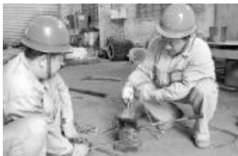
近日,在河南分公司工程公司,修旧利废活动再起高潮。图为员工将进口设备中废弃的引线鼻子接头重新焊接加工,以备再次利用。 邓广顺 张艳华 摄影报道
