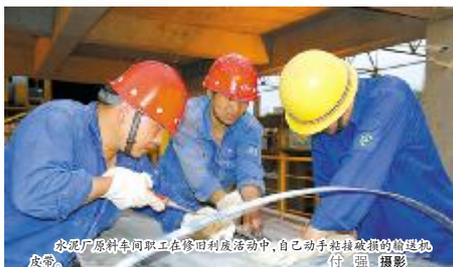
水泥厂原料车间职工在修旧利废活动中,自己动手挂接破旧的传送机皮带。
