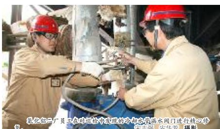
氧化铝二厂员工在对检修中发现的冷却器漏水管进行精心修理。
