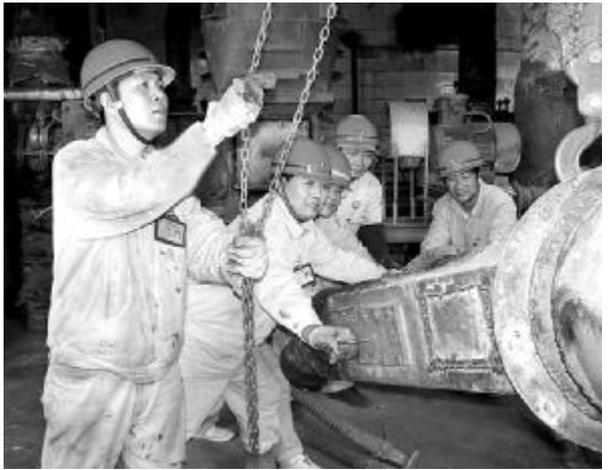
氧化铝一厂四车间钳工班员工于5月10日将2号熟料窑燃器成功修复,彻底改变了以往燃器故障频繁的现象。单价近30万元的变频调速燃器自重达3吨多,内部结构异常复杂,有多根直径大小不等的不锈钢管穿在一起。钳工班班长冯春雷(左一)看到换掉的燃器要报废时,就带领班组成员琢磨起怎样变废为宝。他们经过对燃器内部结构切割、局部更换、铆焊、打磨等程序,最终让废品燃器“复活”。图为拆卸燃器时的情景。
