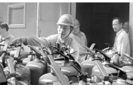
▲5月6日,氧化铝一厂电水车间对所辖变压器室、配电室实用的灭火器进行了集中更换,为配电安全提供了保障。图为员工在更换消防设备。袁建 摄影报道
