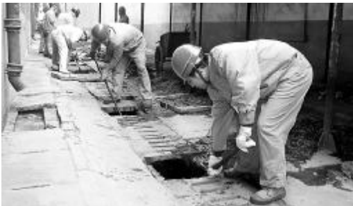
防汛工作是保证企业安全生产稳定运行的前提,尤其是夏季生产组织工作的重中之重。日前,破寨厂对防汛工作提前布置,制订了防汛抢险预案,在雨季到来之前对全厂范围内重点防汛地段的沟渠进行了清理,为夏季的安全生产打下了基础。图为员工在清理排洪沟。刘大海 摄影报道
