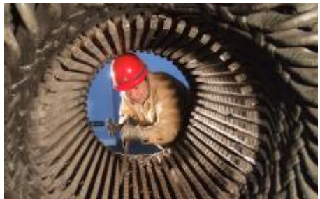
工程公司以打造一流的专业技术队伍为目标,始终如一把氧化铝生产检修工作作为公司的“百年大计”。4月22日,该公司在分公司范围内开展了“安全生产、检修质量、检修效率、检修成本”四大控制、检修维护、检修质量和检修培训”为主题的“六零”系列活动,确保了氧化铝厂一、热电厂、电铝厂等单位大型设备的安全高效运转。图为检修车间员工正在对设备进行检修。 邓广顺 张艳华 摄影报道
