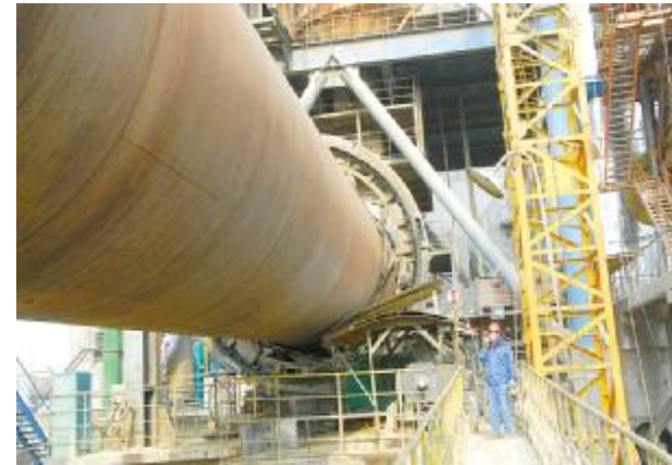
工程施工中5号熟料窑在正常生产。
