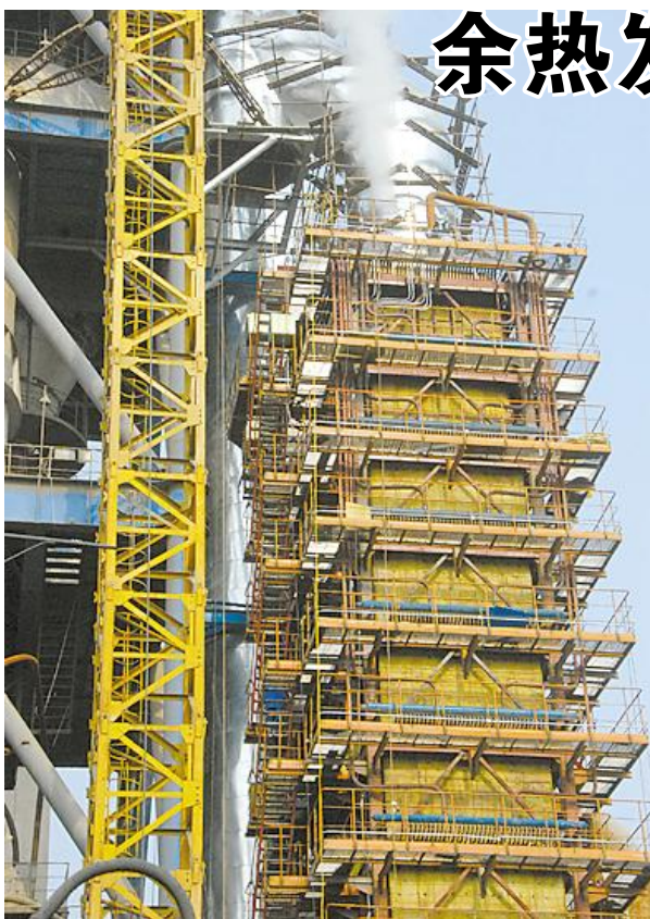
正在建设中的余热发电工程。
