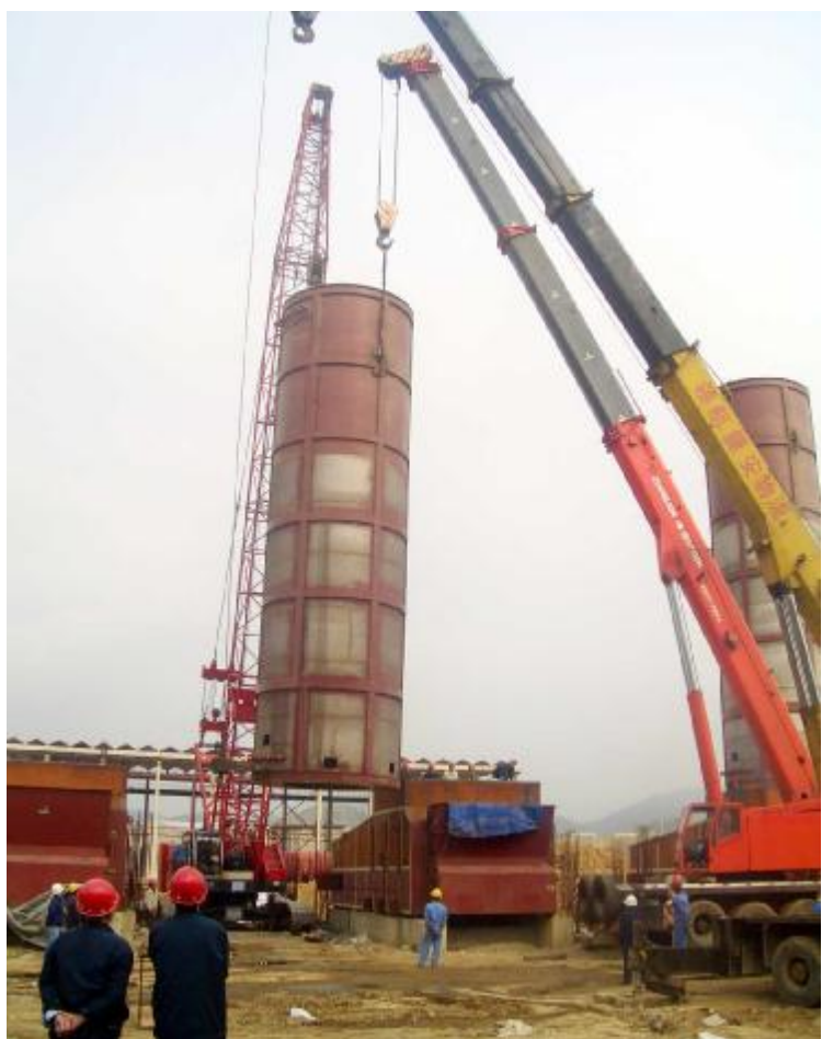
3月30日,由长城铝建设公司承建的遵义氧化铝项目焙盐加热站单体重量78吨的8台焙盐炉吊装成功,使项目建设取得了重大阶段性进展。为确保此次吊装工作的顺利完成,建设公司遵义铝项目部精心安排吊装前的准备工作,确保了吊装一次成功,得到了业主、中铝国际以及监理公司的好评,也为遵义铝项目建设总体目标的顺利实现奠定了坚实基础。图为吊装现场。 杨磊 摄影报道
