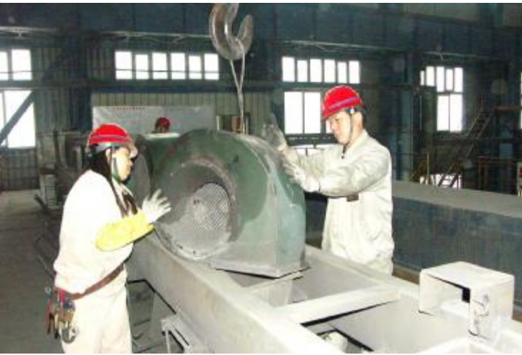
3月份以来,碳素厂积极开展清仓利库、修旧利废活动。图为3月24日,碳素厂检修车间两名员工将刚刚组装好的旧风机电吊装到了现场。 刘海涛 摄影报道
