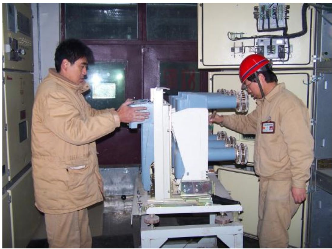
为保障设备安全正常运行,自备电厂电气车间组织员工对重要设备进行了维护和保养。图为员工正在润滑、清扫设备。 楚璐 摄影报道
