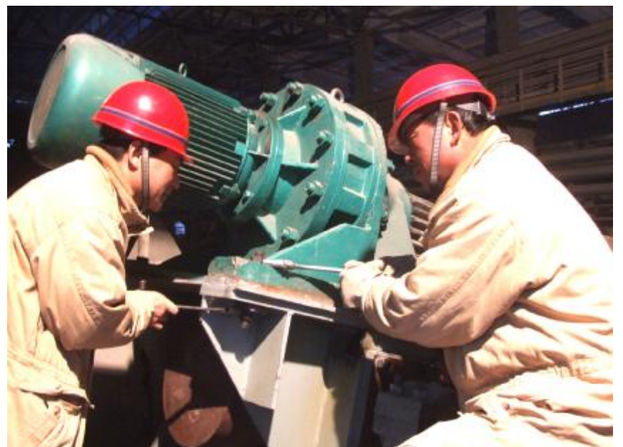
最近,工程公司广泛发动党员围绕企业的中心工作献计献策,组织一线员工苦练内功。图为该公司管道车间共产党员陈晓鹏(右)带领员工正在对氧化铝分级机的电机底座进行技术改造。邓广顺 张艳华 摄影报道
