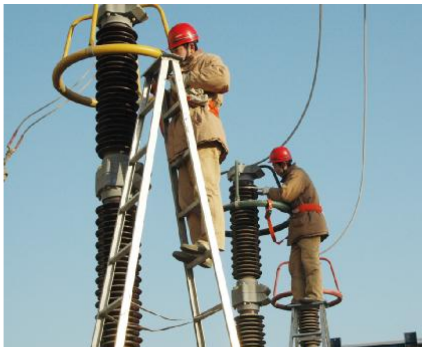
1月12日清晨,自备电厂电气车间的员工在-6℃的天气里,顶着寒风,爬上五六米高的变压器上,对主变压器的各个连接部件和高压瓷瓶绝缘子进行了维护和检查。图为工作现场。武志峰 摄影报道
