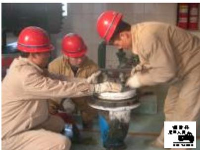
11月17日,水电厂排水车间对清水泵进行预防性维护,修复了拆卸后的备件,节约了备件更换费用近两千元。图为检修班员工正在清理水泵上的结垢。 康宏伟 摄影报道
