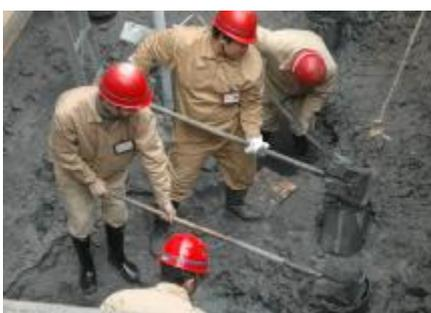
经过前期的运行,自备电厂热机车间灰浆池下面沉积了大量灰浆块。11月12日,车间全体员工对灰浆池进行了清理。图为热机车间员工在清理灰浆池里的灰浆块。 谷恒良 刘敬 摄影报道
