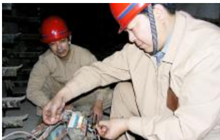
10月9日,水电厂电讯车间对机房至电解交接箱300对被损坏的主干通信电缆进行了修复。图为外线员工在对通信电缆进行检修。陈文峰 摄影报道
