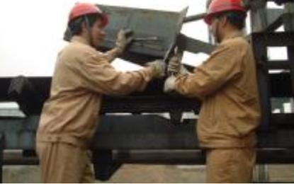
6月24日,自备电厂7号皮带卸料犁架碾磨两侧碾磨严重,检修车间员工采用提升卸料犁架板的方法,使煤粉顺利进入煤仓。图为该车间员工正在调整卸料犁架板。 王霞 摄影报道
