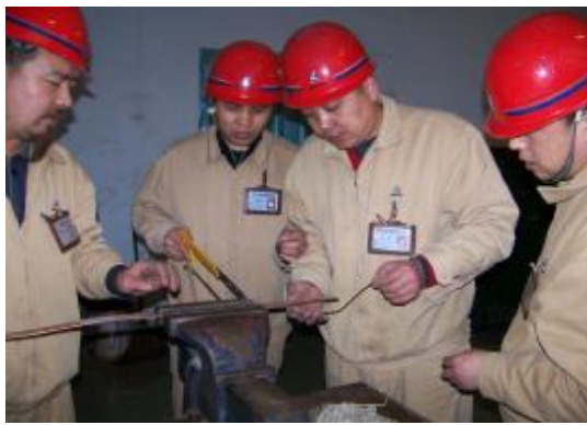
近日,氧化铝厂电仪车间两党小组成员分别完成了74、62配电室部分盘路的改造工作。图为党员在制作盘路母线。
