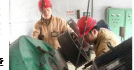
为确保护水零排放,水电厂排水车间钳工班按照春季检修计划,对2号螺旋泵减速机进行了保养维护。李相宇 康宏伟 摄影报道
