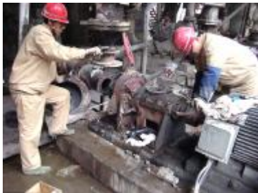
近日,氧化铝一厂车间钳工班保质保量完成了“163”循环泵”检修任务。图为员工正在检修现场作业。 董爱东 摄影报道
