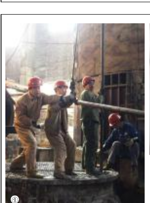
3月6日,机械制造公司大修车间接到了氧化铝一厂七车间六组一就蒸发器的检修任务。车间领导高度重视,立即组织检修人员进入现场,详细制订了检修方案,打破班组界限,整合检修人员,有效解决了人员紧张的困难,圆满完成检修任务。 ①检修人员在拆卸蒸发器筒体。 ②检修人员在拆卸蒸发器筒体。 ③检修人员现场研究检修方案。 张德文 王冬梅 摄影报道
