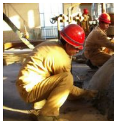
最近,氧化铝一厂电气车间将有用的报废元件重组再行利用。图为员工正在安装重组再用的元器件。 袁媛 摄影报道
