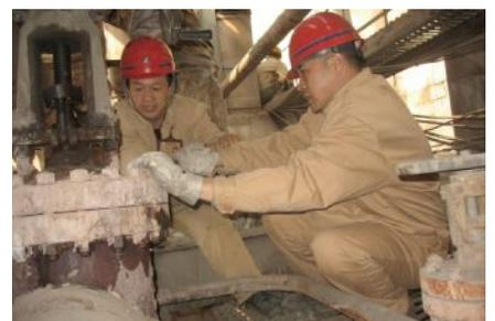
近日,热电厂对22管道上的201号阀门进行了抽芯检查,确保了该设备在冬季的安全运行。
