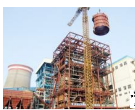
由工程公司承建的自备电厂2号锅炉工程,经过施工人员的紧张施工,目前,主体结构已基本竣工,其设备安装正在进行。
