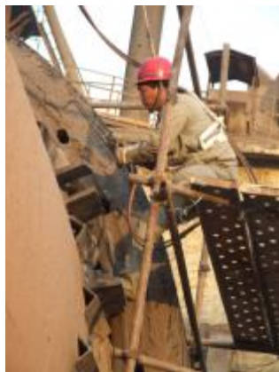
原料车间是水泥生产的源头车间,有3台磨机、1台破碎机、1台皮带输送机磨料设备改造成功之后,经改造过的生料由皮带直接接入2号磨内,减少了天车抓料环节,降低了天车用电量。
