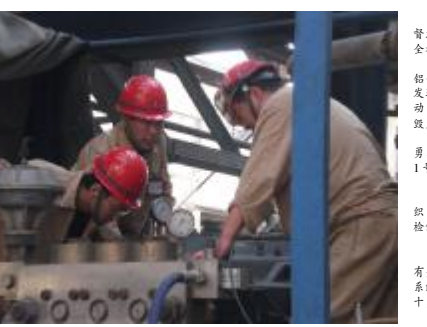
为保持氧化铝生产高产,提高清洗工作效率,近日氧化铝一厂检修站领导及清洗班人员对4号清洗水高压泵曲轴箱系统进行了维护保养。
